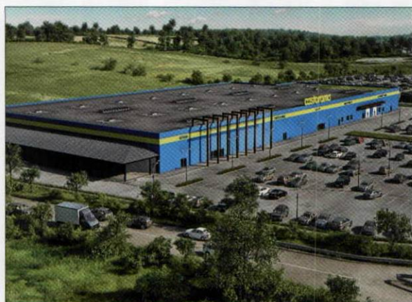
■ Рис. 1. Торгово-складской комплекс «Касторама»
