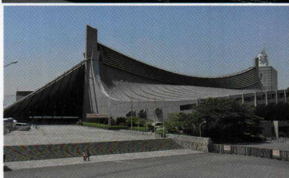
■ Рис. 2. Большой крытый стадион The Yoyogi National Gymnasium, Токио. На торце здания видны направляющие сопла
