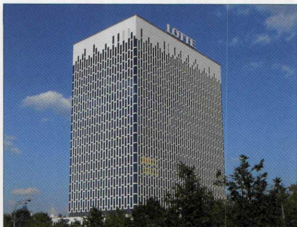
■ Внешний вид офисного здания
