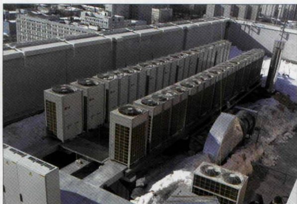
■ Расположение наружных блоков на кровле
