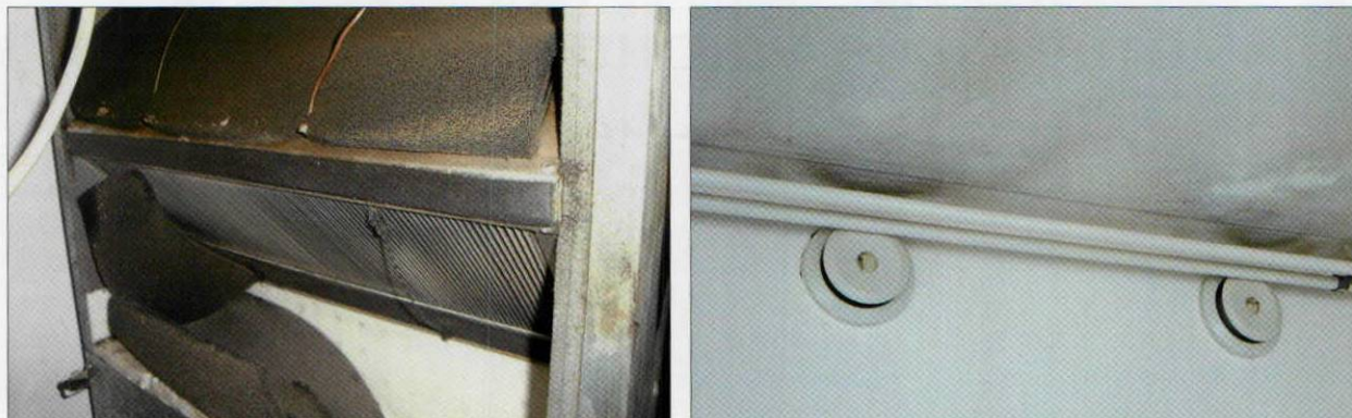
■ Рис. 2. Слева: несвоевременная замена фильтров может привести к их разрушению, что видно на примере нижнего фильтра. Справа: неверный подбор анемостатов (расположение и несоблюдение скорости воздуха на выходе из устройства) может привести к появлению следов грязи и пыли
